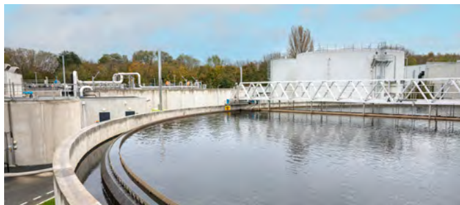
Station d'épuration de Bourge Plus (18)
