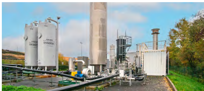
Centre d'enfouissement de Saint-Palais (18)
